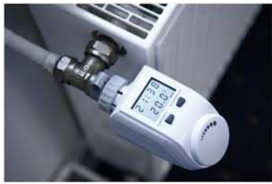
U slučaju da se grejanje stanova ostvaruje vrelom vodom isporučenom iz **sistema daljinskog grejanja**, kao meru energetske efikasnosti koja se odnosi na regulaciju, moguće je primeniti meru ugradnje termostatski radijatorskih ventila, čime će se uštedeti do čak do 20% energije. U slučaju da se naplata usluge grejanja vrši na osnovu stvarno potrošene energije, za skoro isti iznos smanjiće se i račun za grejanje.
