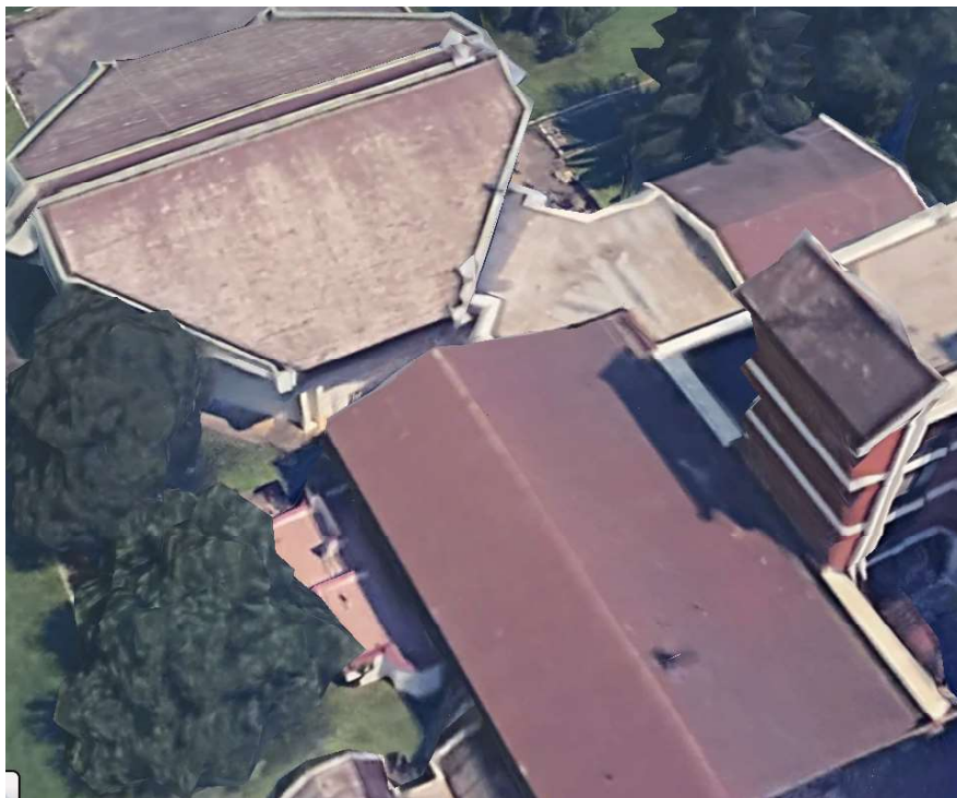
Слика 25 Коси кров прекривен етерит плочама – КК2, реални приказ
