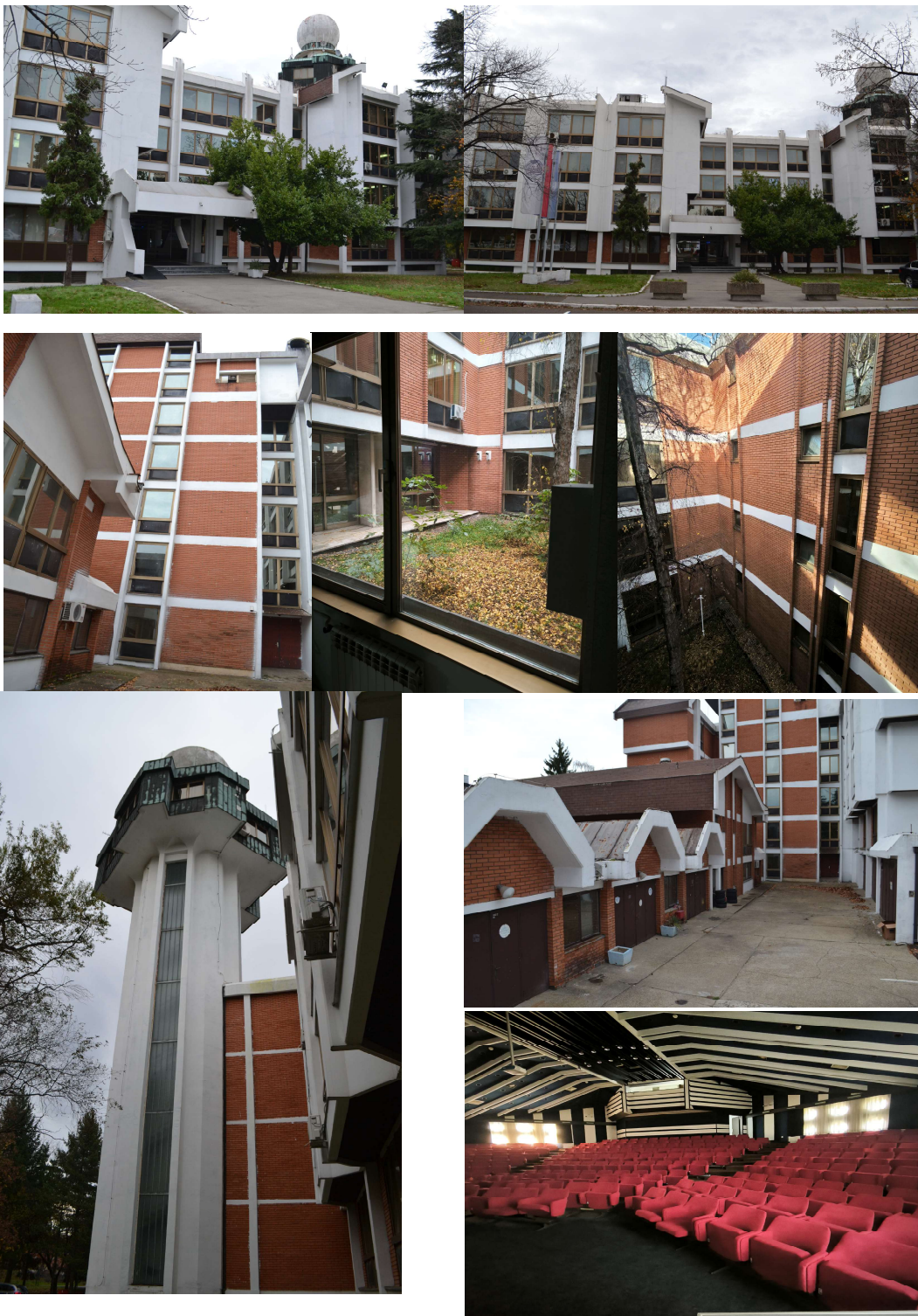
Слика 32 Изглед објекта
