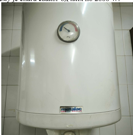
Слика 42 Изглед бојлера за припрему санитарне топле воде у тоалету
