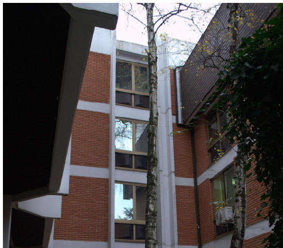
Слика 29 Алуминијумски прозори на источној фасади објекта
