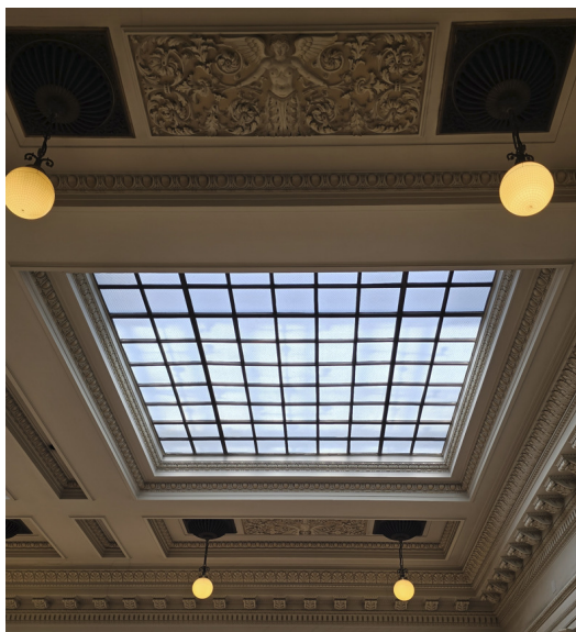
Слика 40: Изглед дистрибутивних елемената за убацивање ваздуха који представљају носаче за лустере
