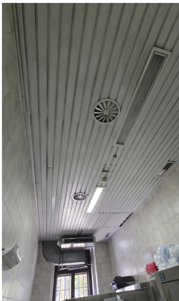
Слика 75: Изглед дистрибутивних елемената за вентилациони систем кухиње
