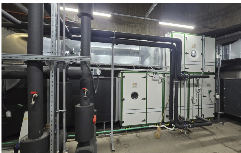
Слика 38: Изглед клима коморе система К-2
