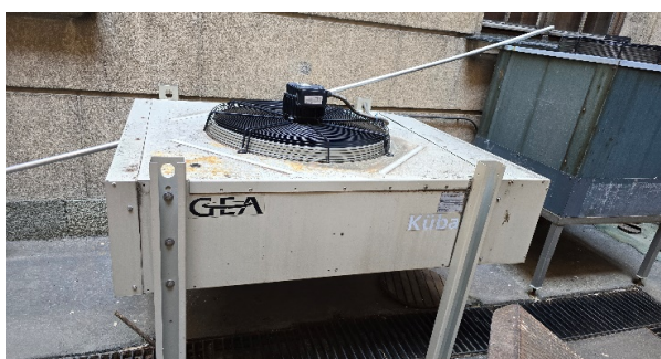
Слика 57: Ваздухом хлађени кондензатор
