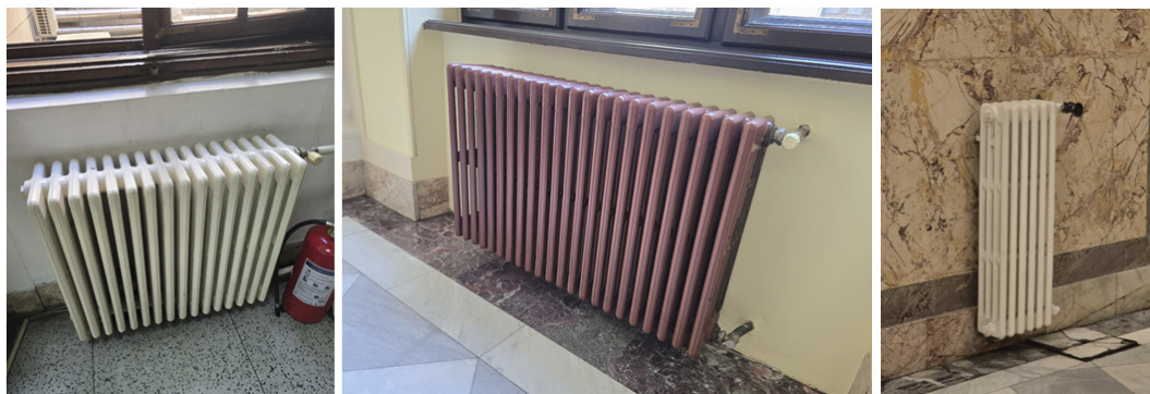
Слика 28: Приказ грејних тела у систему грејања - радијатори
