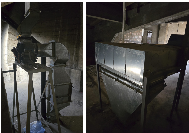
Слика 72: Приказ каналских вентилатор конвектора за велику и малу одборничку салу
