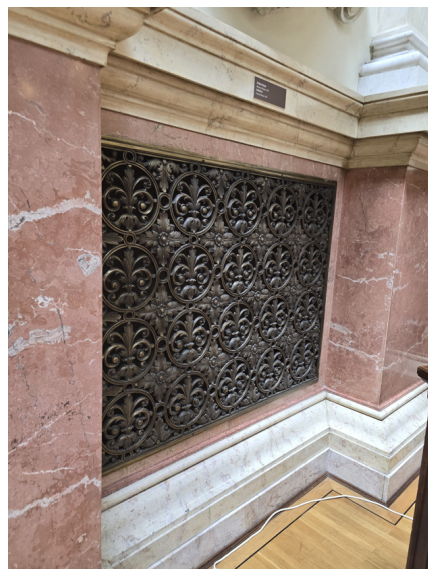
Слика 41: Изглед дистрибутивних елемената за извлачење ваздуха
