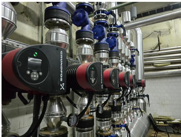
Слика 26: Приказ фреквентно регулисаних циркулационих пумпи на разделнику топле воде
