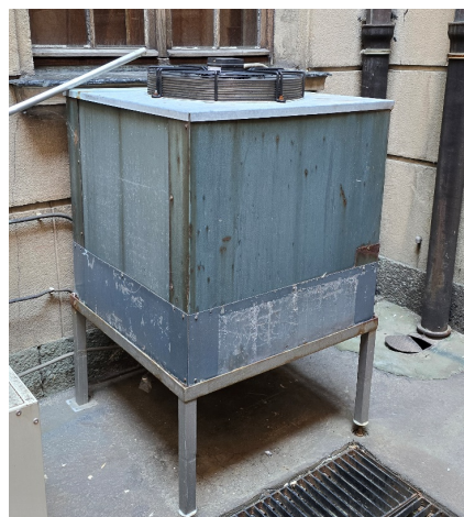
Слика 62: Ваздухом хлађени кондензатор
