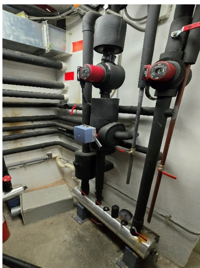
Слика 68: Изглед разделника топле воде за систем К-9
