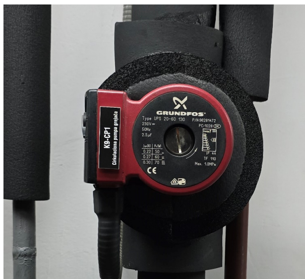
Слика 69: Циркулациона пумпа грејача клима коморе
