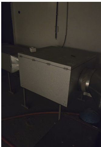
Слика 51: Изглед каналског вентилатора за извлачење ваздуха испод подијума председништва (систем К-4-о.2)
