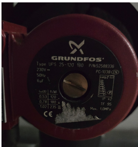
Слика 70: Циркулациона пумпа за хладњака клима коморе
