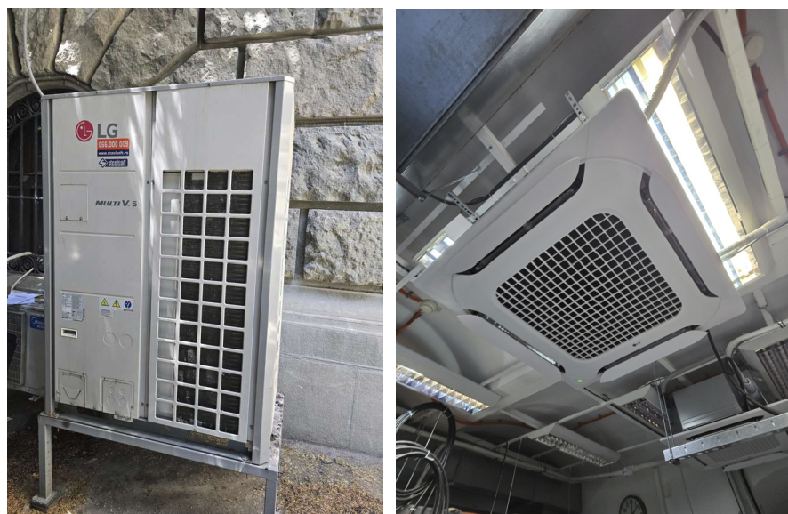
Слика 93: Приказ спољашњих и унутрашњих јединица уређаја за хлађење дата центра
