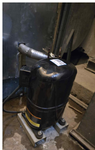
Слика 56: Компресор клима коморе система К-5
