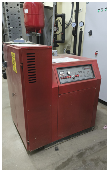
Слика 96: Приказ електричног котла тип E-TechP
