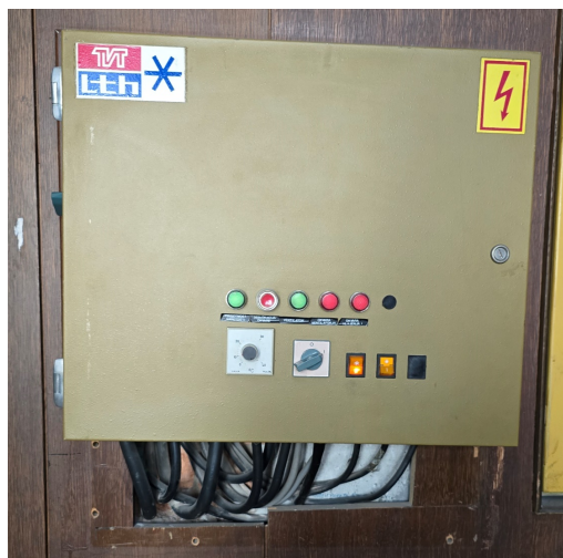
Слика 65: Разводни орман система К-8
