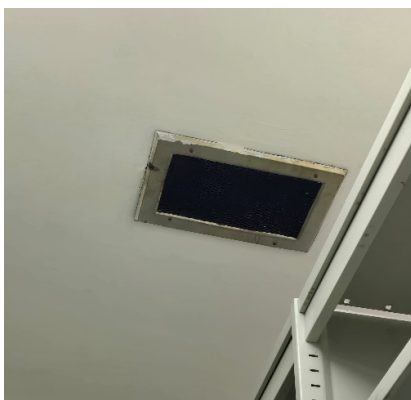
Слика 63: Вентилациона решетка за убацивање ваздуха
