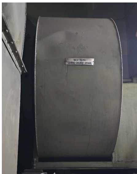
Слика 36: Изглед вентилатора за убацивање и извлачење отпадног ваздуха
