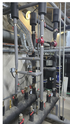
Слика 39: Изглед разделника и сабирника са циркулационим пумпама за К-2 и В-17
