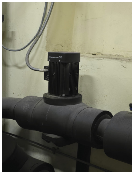
Слика 32: Приказ циркулационе пумпе тип: "Grundfos" MG90LC2
