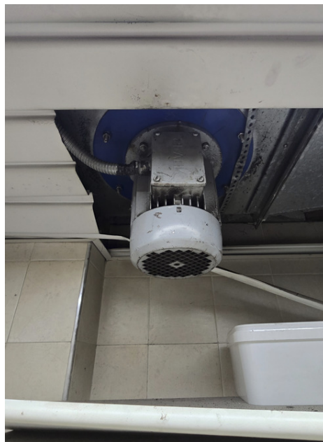
Слика 76: Изглед електромотора вентилатора
