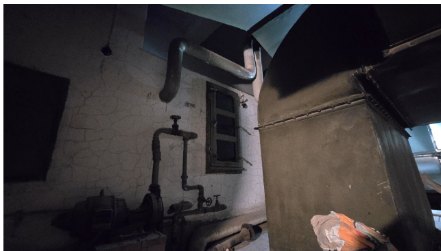
Слика 34: Изглед зидане клима коморе система К-1
