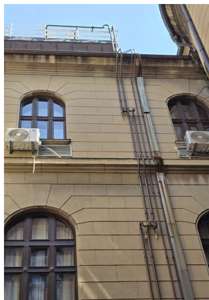
Слика 33: Приказ фреонског развода цевне мреже
