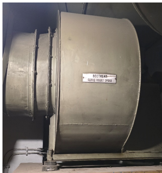
Слика 37: Изглед вентилатора за убацивање свежег ваздуха
