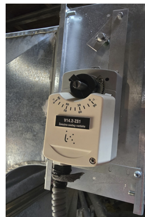
Слика 80: Електромоторни актуатор жалужине свежег ваздуха
