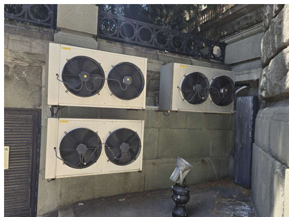
Слика 94: Приказ клима ормана и ваздухом хлађеног кондензатора дата центра
