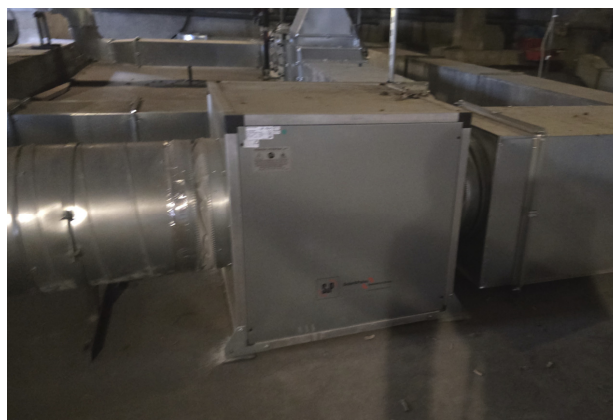
Слика 42 : Изглед каналског вентилатора за локални одсис К-2-02 из кафе клуба
