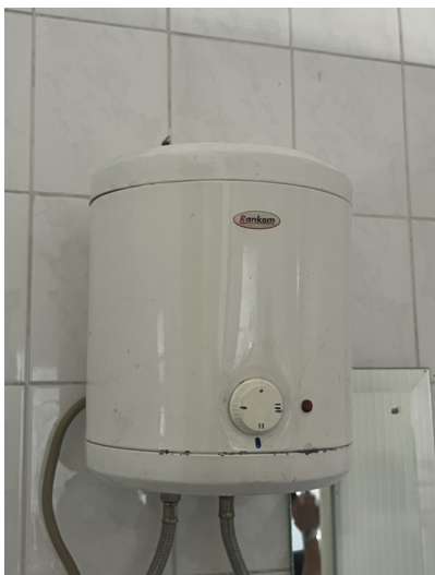
Слика 99: Приказ електричног бојлера за припрему санитарне топле воде
