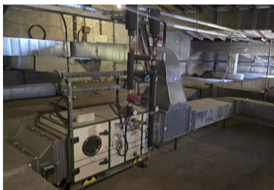
Слика 83: Изглед клима коморе за светларнике изнад сале за разговоре
