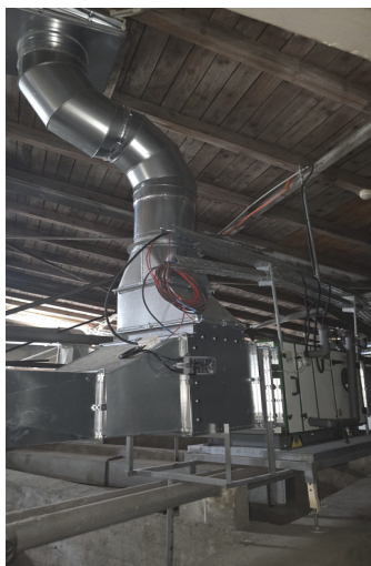
Слика 86: Изглед каналског развода
