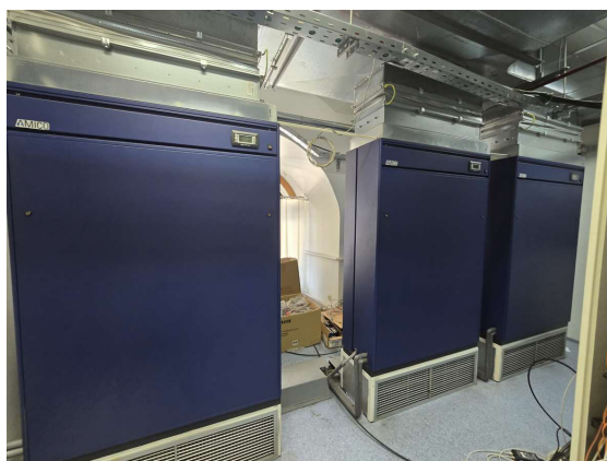
Слика 94: Приказ клима ормана и ваздухом хлађеног кондензатора дата центра
