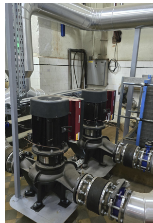
Слика 27: Приказ радне и резервне циркулационе пумпе
