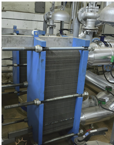
Слика 24: Приказ плочастог размењивача топлоте
