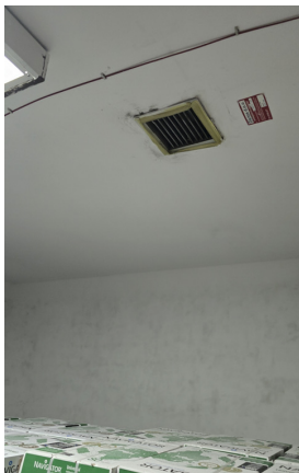
Слика 90: Изглед вентилационе решетке за извлачење ваздуха
