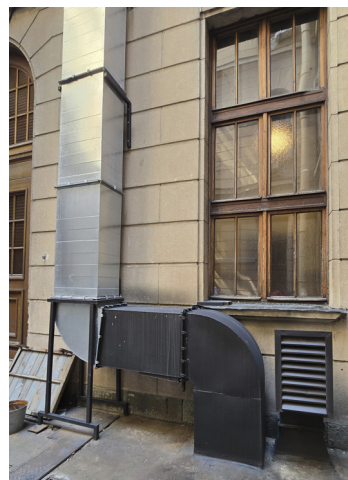
Слика 74: Изглед канла за извлачење масних пара
