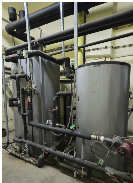
Слика 95: Приказ централних бојлера за санитарну топлу воду
