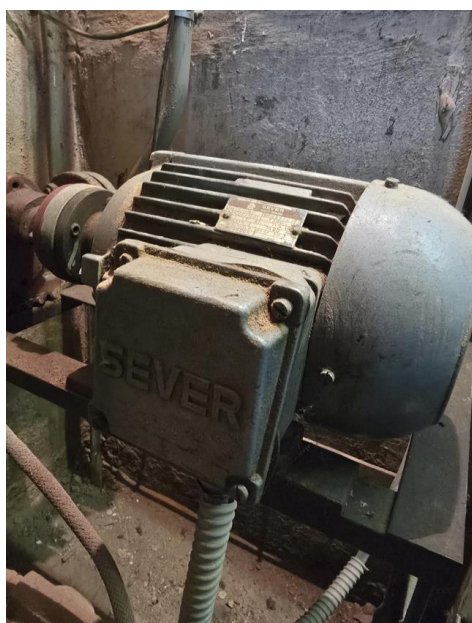
Слика 24: Приказ циркулационе пумпе тип: SEVER Суботица: ZK90L4
