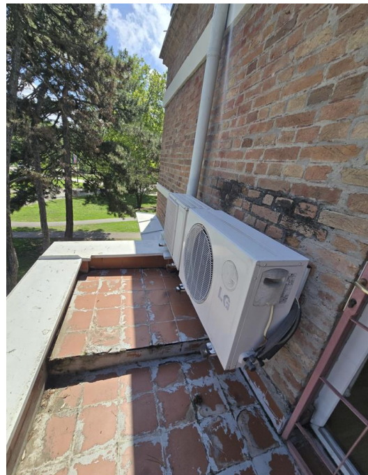
Слика 28: Спољне јединице уређаја за хлађење просторија постављене на тераси спрата на адреси Ташмајдански парк б.б. (сплит систем)
