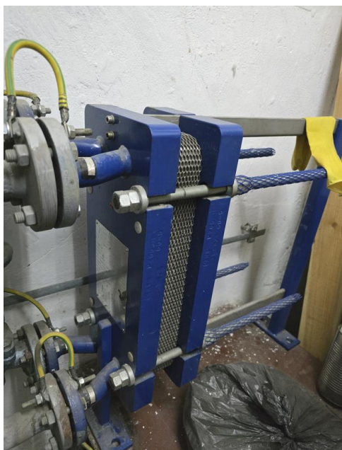
Слика 22: Приказ плочастог размењивача топлоте
