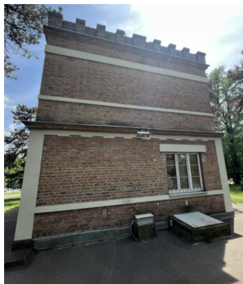
Слика 9: Фасада са северне стране објекта
