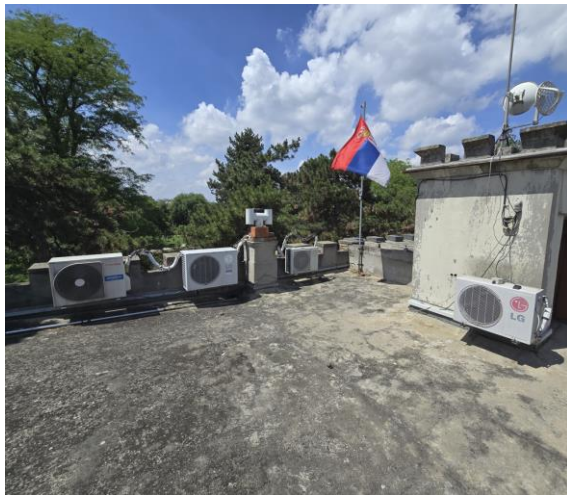
Слика 27: Спољне јединице уређаја за хлађење просторија постављене на крову зграде на адреси Ташмајдански парк б.б. (сплит систем)
