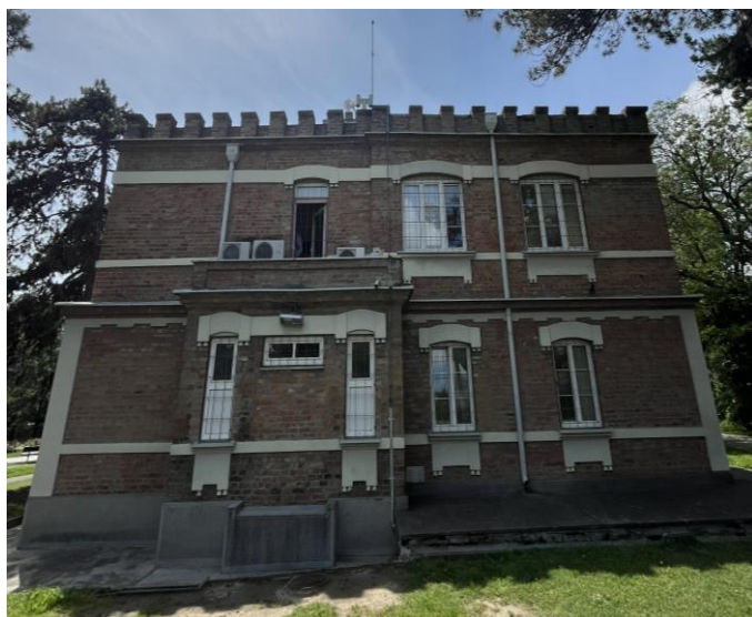
Слика 8: Фасада са источне стране објекта
