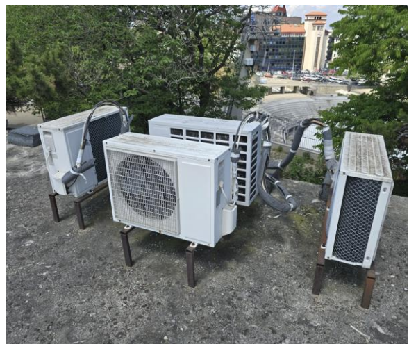
Слика 27: Спољне јединице уређаја за хлађење просторија постављене на крову зграде на адреси Ташмајдански парк б.б. (сплит систем)
