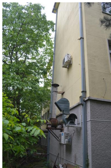
Слика 26 Изглед западне фасаде – поглед из дворишта
