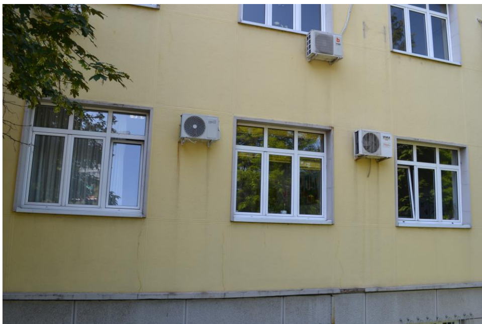
Слика 18: Изглед спољашње јединице сплит уређаја на фасадном зиду
