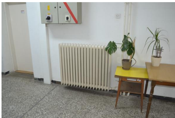
Слика 17: Изглед типичних грејних тела - радијатора
