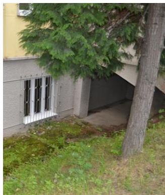
Слика 21 ПВЦ прозор на северној фасади објекта
