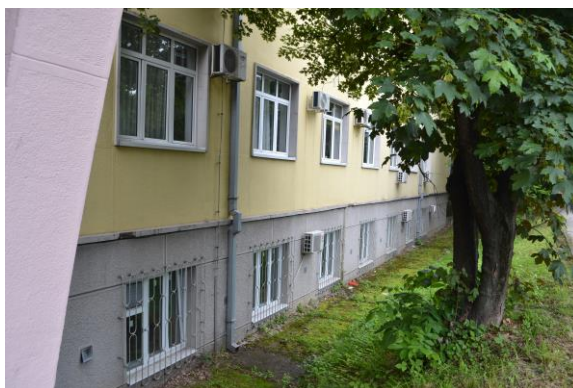
Слика 8 Северна страна фасаде објекта и приказ зида у тлу
