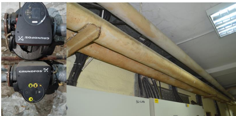
Слика 29 Циркулационе пумпе GRUNDFOS, тип Magna 3 и топлотноизолована цевна мрежа унутар термичког омотача
