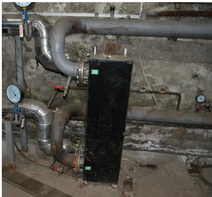
Слика 28 Плочасти размењивач топлоте DANFOSS XB70L-1-80_2
