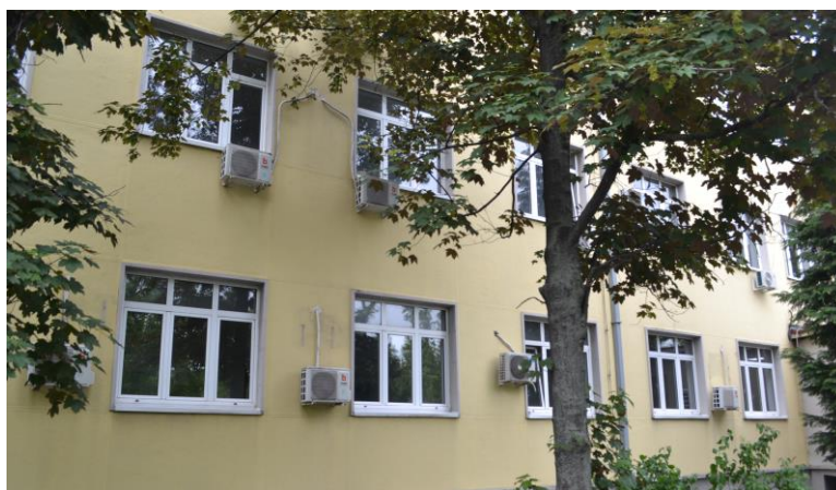
Слика 19 Алуминијумски прозори на северној фасади објекта
