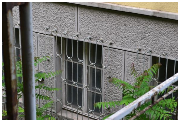
Слика 20 Дрвени прозори на источној фасади објекта
