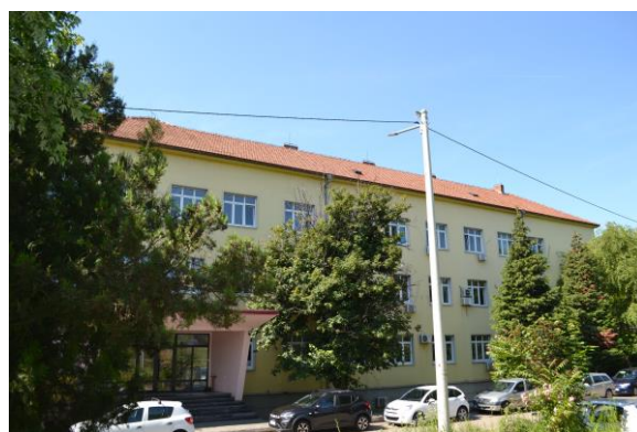
Слика 24 Изглед северне фасаде – поглед из Ровињске улице
