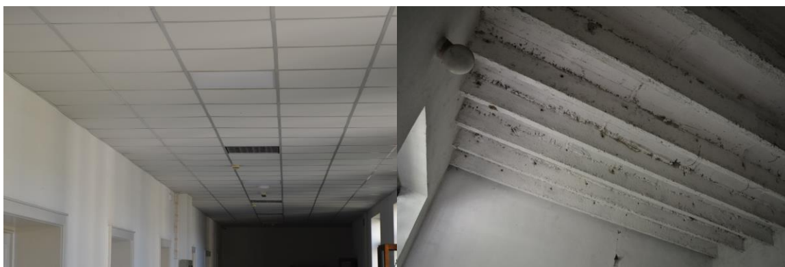
Слика 15 Армстронг спуштени плафон и Авраменко међуспратна конструкција
