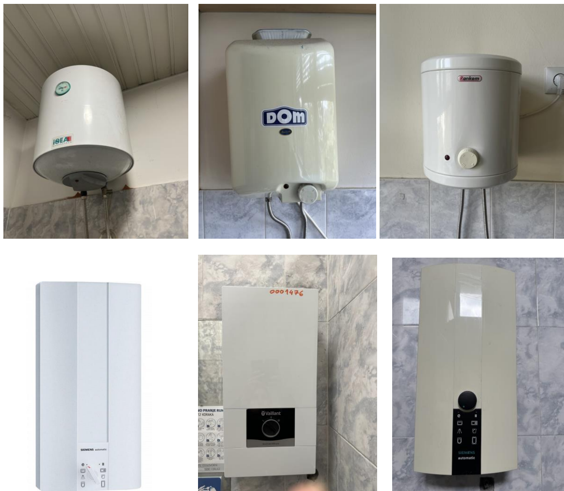
Слика 19: Изглед бојлера за припрему санитарне топле воде у тоалету
