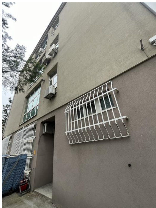
Слика 7: Фасада са североисточне стране објекта
