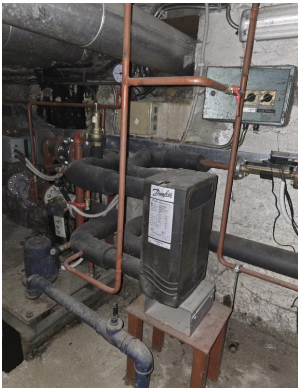
Слика 17: Приказ размењивача топлоте тип: Danfoss Trata, Danska, тип: XB52M-1-10/079B0938 номиналног капацитета 400 kW
