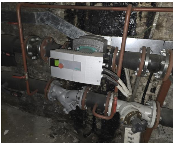
Слика 19: Приказ циркулационе пумпе тип: Wilo, модел: Stratos 50/1-16
