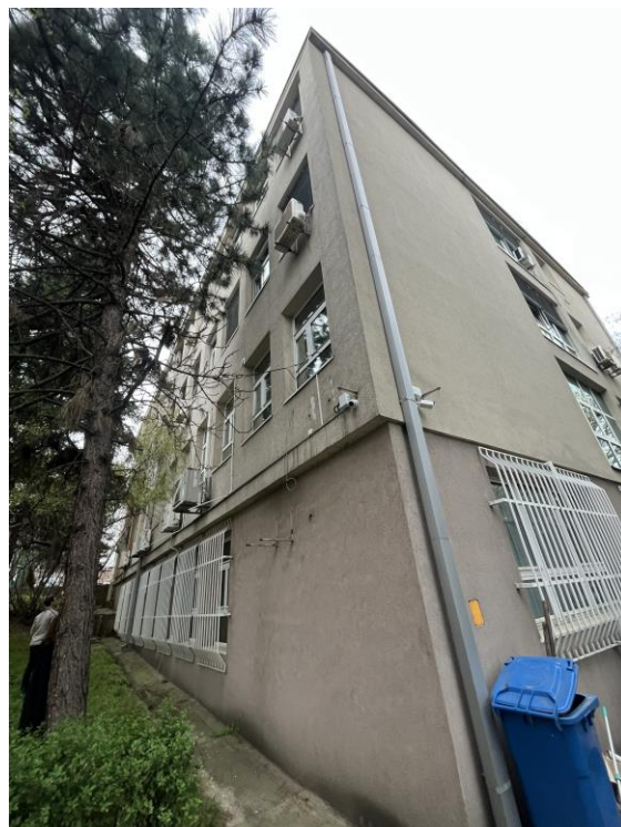
Слика 9: Фасада са југоисточне стране објекта
