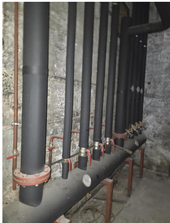
Слика 18: Приказ разделника и сабирника топле воде
