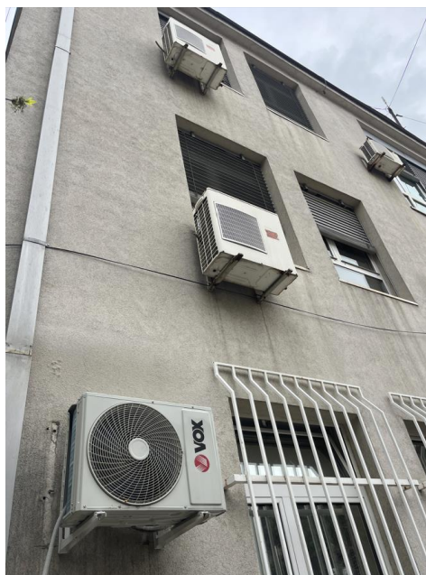
Слика 22: Изглед спољашње и унутрашње јединице сплит уређаја на фасадном зиду
