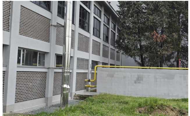
Слика 19: Приказ развода гасне инсталације на улазу у објекат Дома спорта
