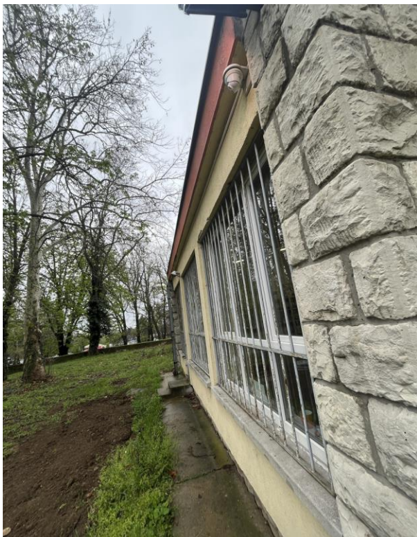
Слика 6: Фасада са јужне стране објекта
