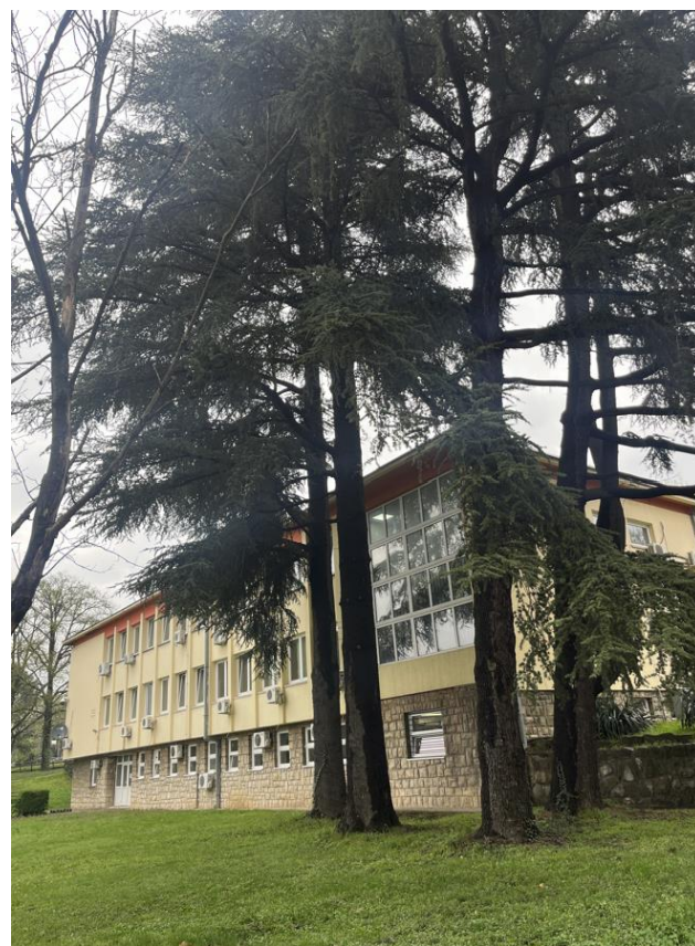
Слика 8: Фасада са западне стране објекта
