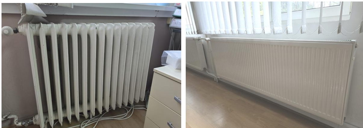
Слика 22: Изглед типичних грејних тела - радијатора
