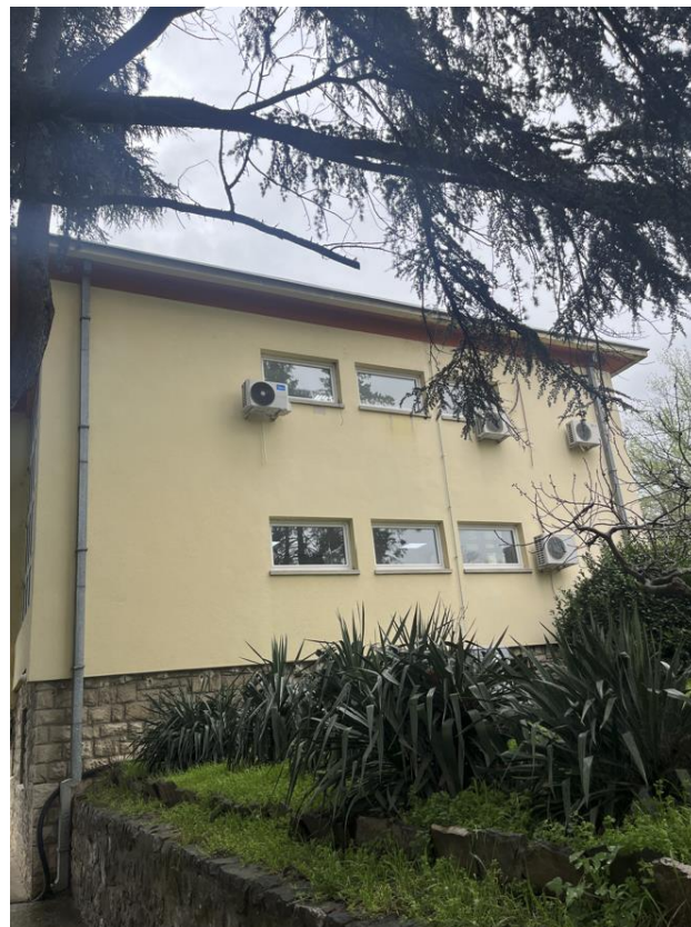
Слика 6: Фасада са јужне стране објекта
