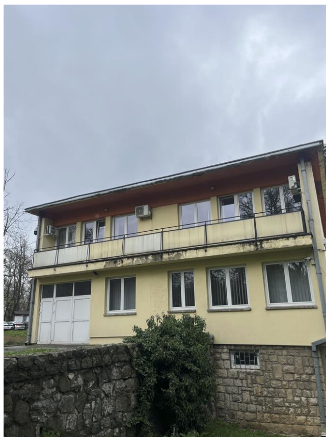
Слика 7: Фасада са северне стране објекта
