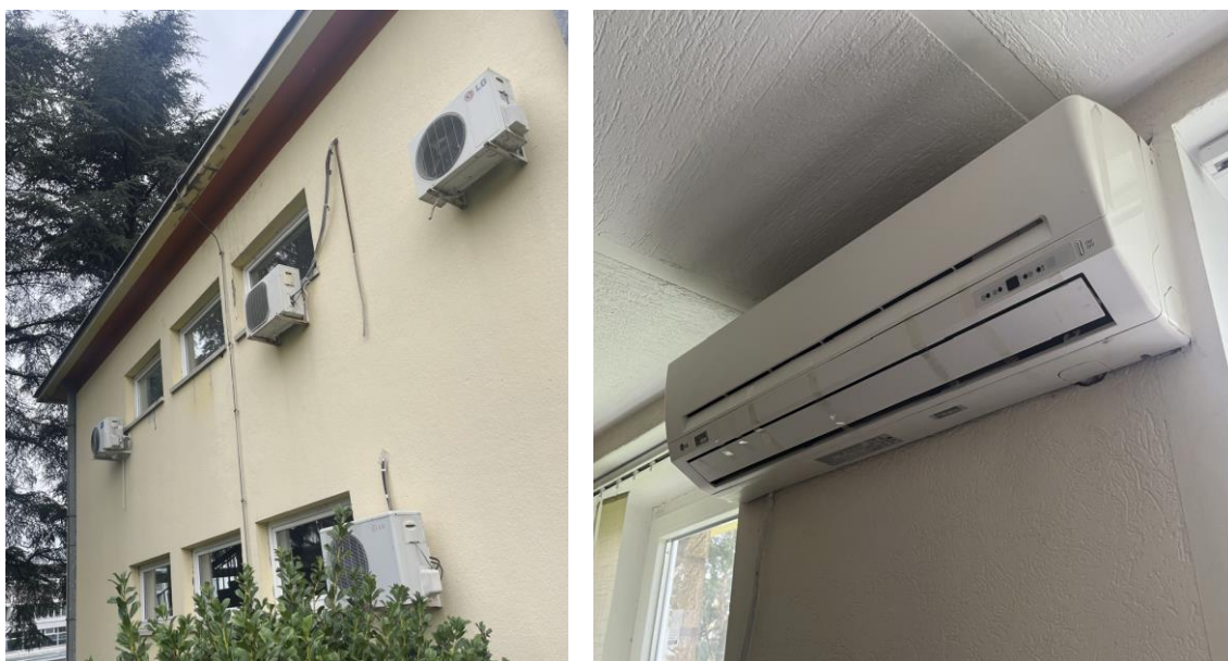
Слика 23: Изглед спољашње и унутрашње јединице сплит уређаја
