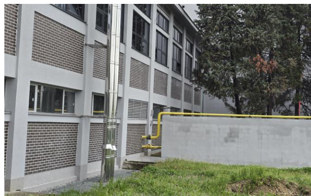
Слика 19: Приказ развода гасне инсталације на улазу у објекат Дома спорта
