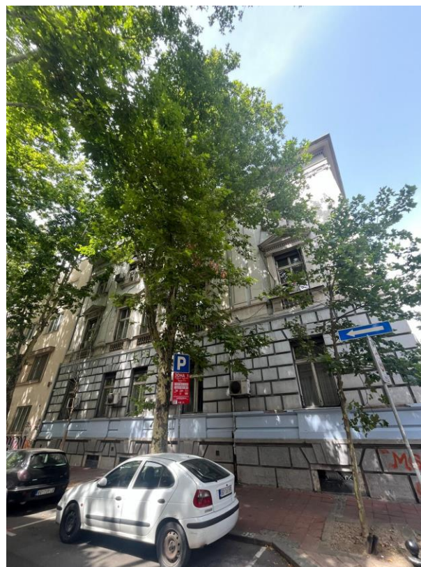
Слика 8: Фасада са југо-западне стране – поглед из Симине улице
