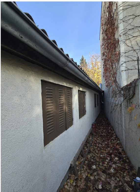
Слика 6: Фасада са јужне стране објекта
