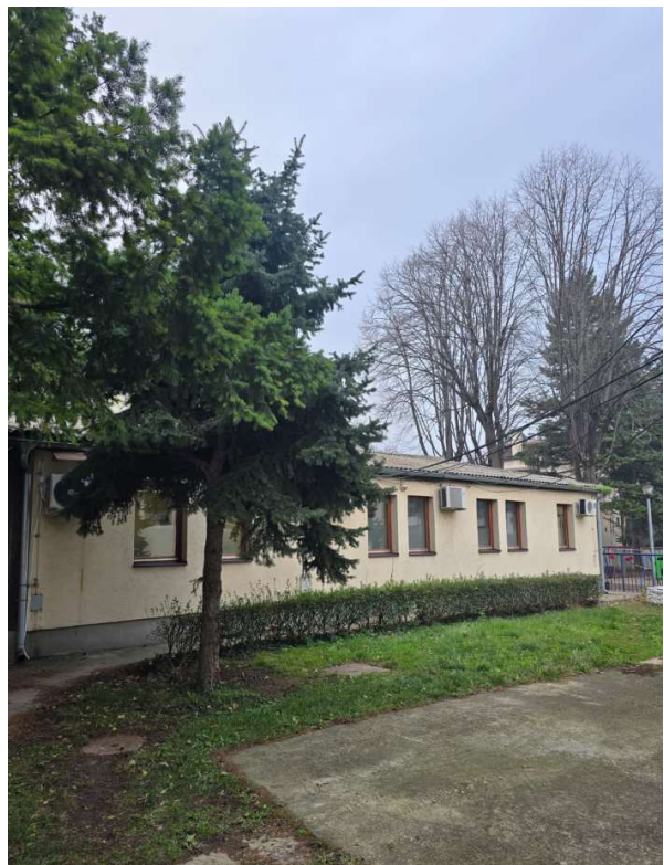
Слика 7: Фасада са западне стране објекта
