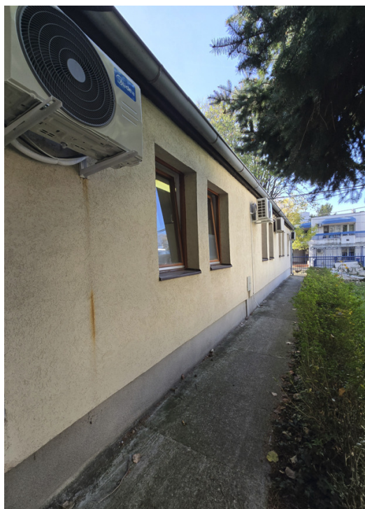
Слика 8: Фасада са северне стране објекта
