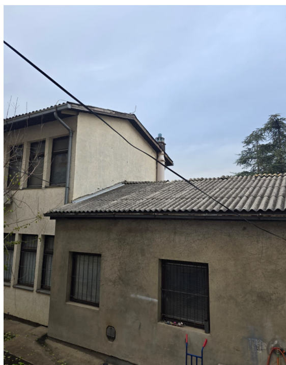
Слика 11: Фасада са северне стране објекта
