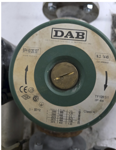
Слика 18: Приказ циркулационе пумпе тип: DAB, модел BPH 60/280.50T
