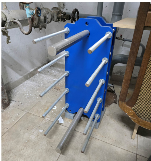
Слика 16: Приказ размењивача топлоте: Euro heat, Србија, тип: TR 100-034 номиналног капацитета 200 kW
