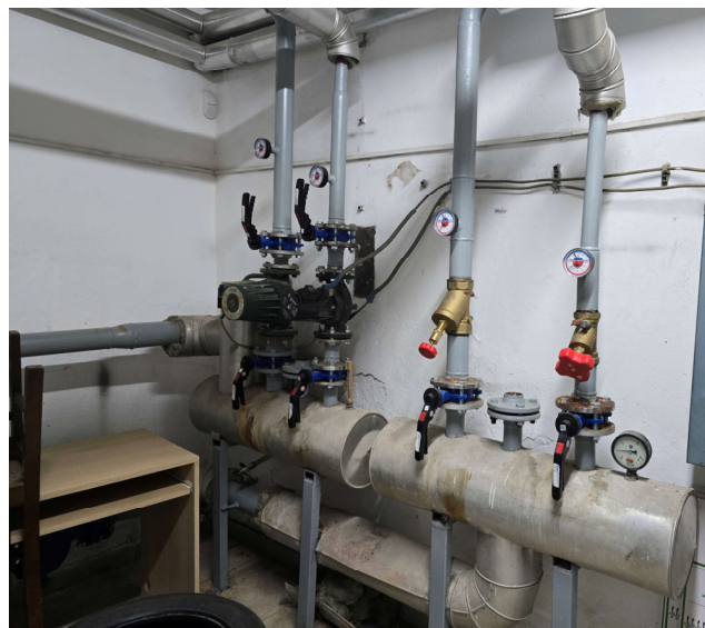
Слика 17: Приказ разделника и сабирника топле воде
