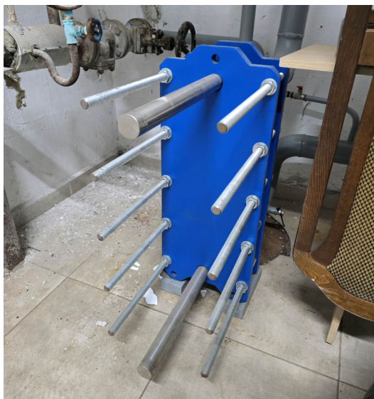
Слика 22: Приказ размењивача топлоте: Euro heat, Србија, тип: TR 100-034 номиналног капацитета 200 kW
