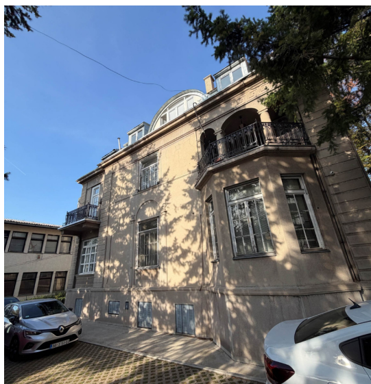
Слика 14: Фасада са јужне стране објекта
