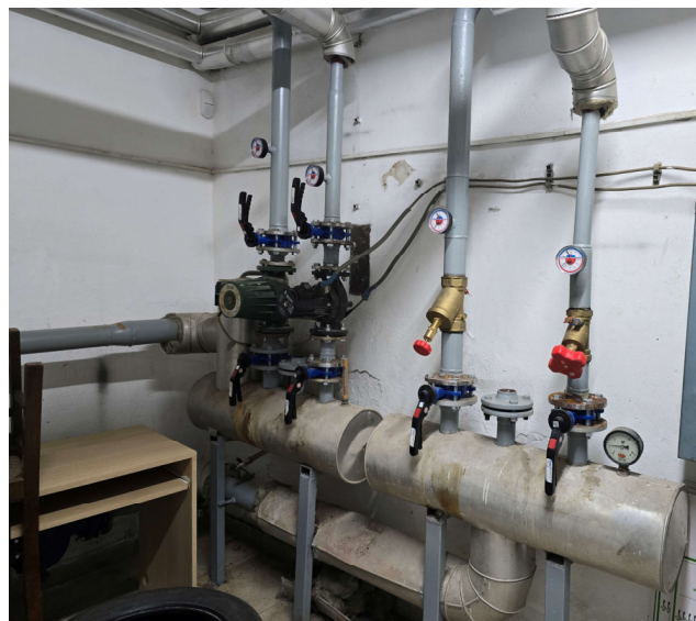
Слика 23: Приказ разделника и сабирника топле воде
