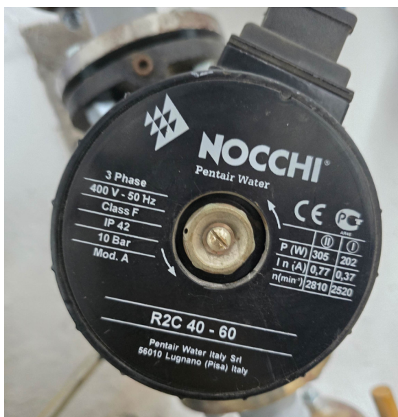
Слика 24: Приказ циркулационе пумпе тип: Nocchi, модел R2C 40-60
