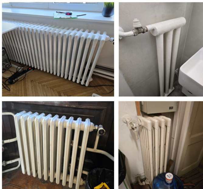
Слика 26: Изглед типичних грејних тела - радијатора
