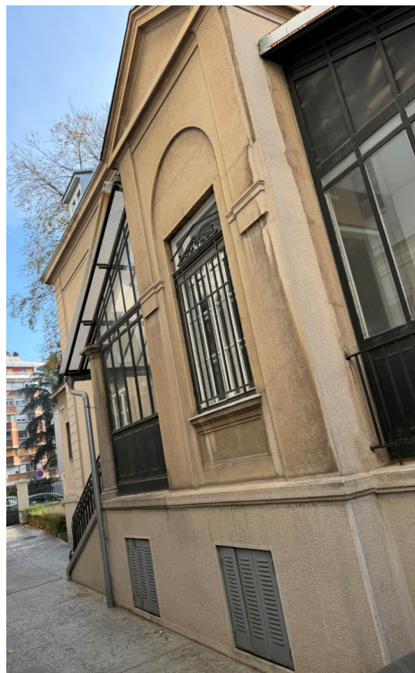
Слика 12: Фасада са северне стране објекта
