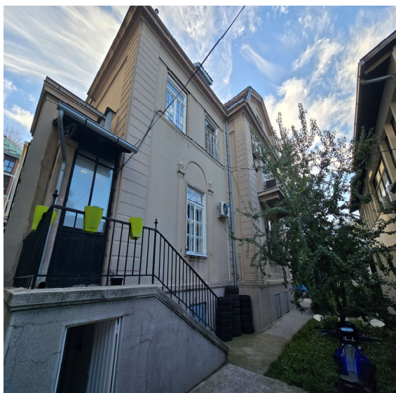
Слика 13: Фасада са западне стране објекта
