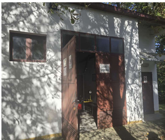
Слика 23: Приказ гасне котларнице
