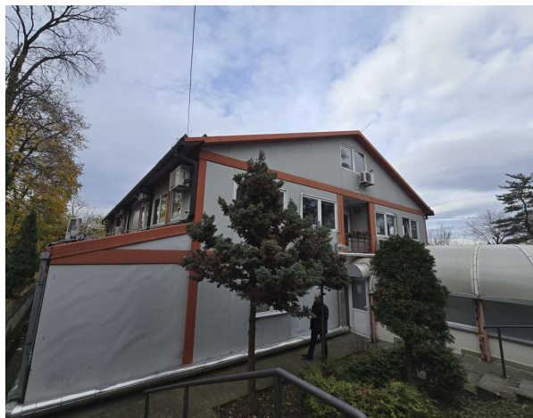
Слика 14: Фасада са североисточне стране објекта
