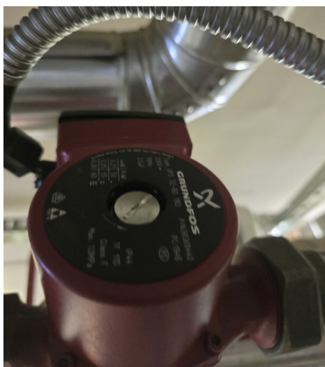
Слика 53: Приказ циркулационе пумпе тип: "Grundfos" UPS 32-60-180
