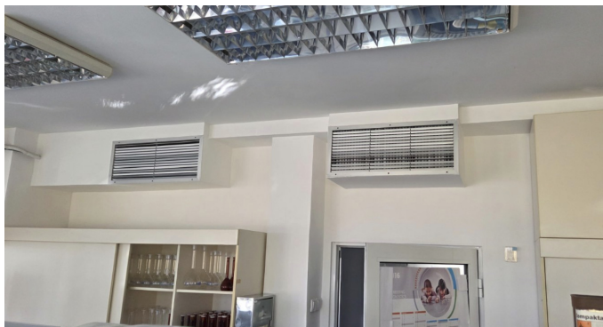
Слика 35: Приказ алуминијумских вентилационих решетки за убацивање и извлачење ваздуха
