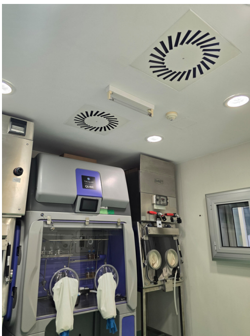
Слика 47: Приказ дистрибутивних елемената за убацивање ваздуха – вртложни дифузори
