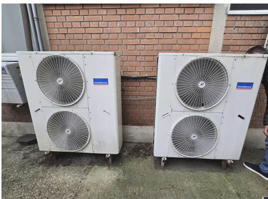
Слика 32: Приказ спољашње јединице произвођача Tadiran тип: ANL903
