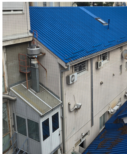
Слика 14: Фасада са југозападне стране објекта
