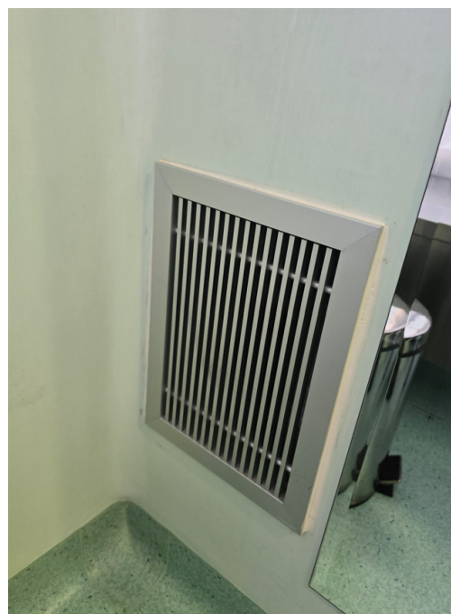
Слика 48: Приказ дистрибутивних елемената за извлачење ваздуха – вентилационе решетке
