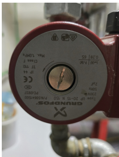
Слика 54: Приказ циркулационе пумпе ка потрошачима тип: "Grundfos" UP 20-15 N 150
