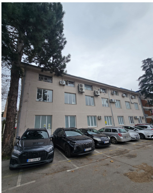
Слика 11: Фасада са северозападне стране објекта
