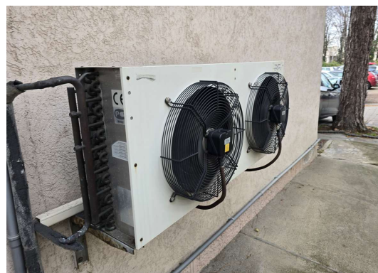
Слика 44: Приказ ваздухом хлађеног кондензатора
