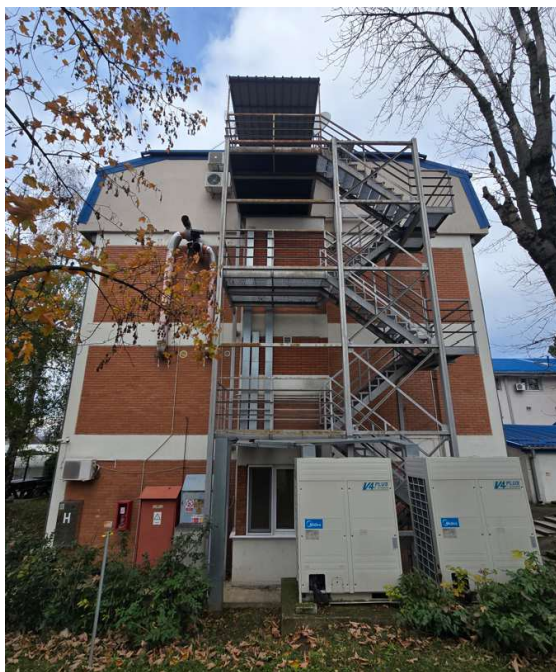
Слика 17: Фасада са југоисточне стране објекта
