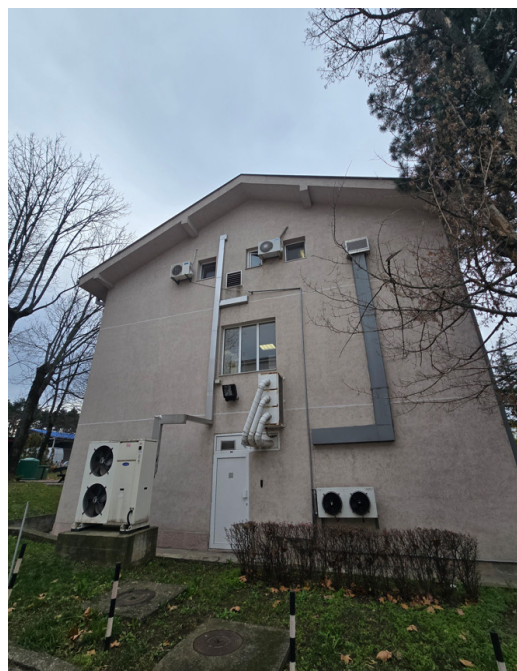
Слика 12: Фасада са североисточне стране објекта
