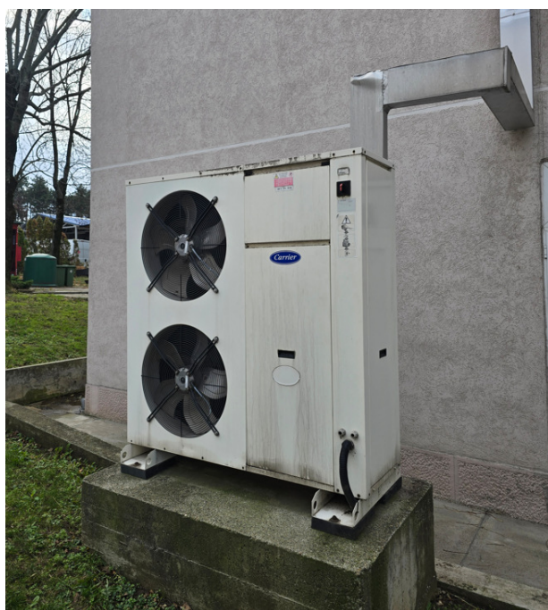
Слика 37: Приказ чилера произвођача "Carrier" тип 30RH026
