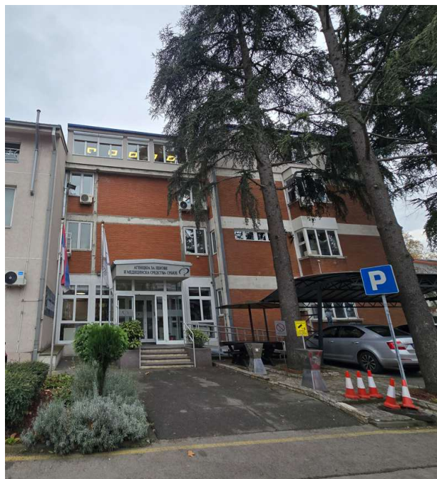
Слика 18: Фасада са северозападне стране објекта
