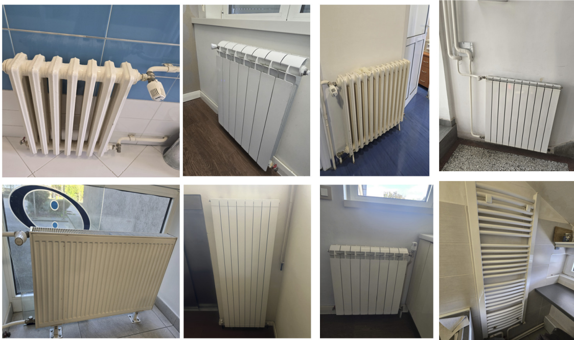
Слика 29: Грејна тела система грејања зграде у улици Булевар војводе Степе 458
