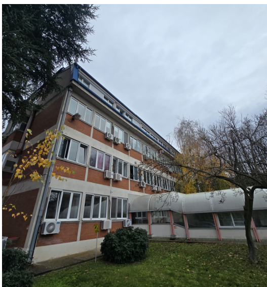
Слика 15: Фасада са југозападне стране објекта
