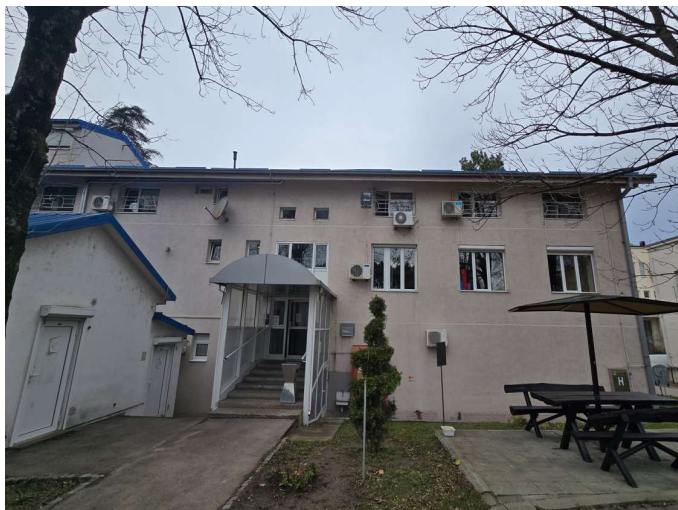
Слика 13: Фасада са југоисточне стране објекта
