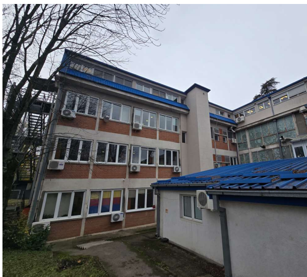
Слика 16: Фасада са североисточне стране објекта
