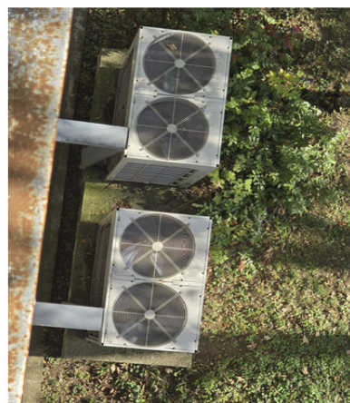
Слика 36: Приказ спољашње јединице произвођача Midea тип: MDV-400(14)W/DRN1(B)
