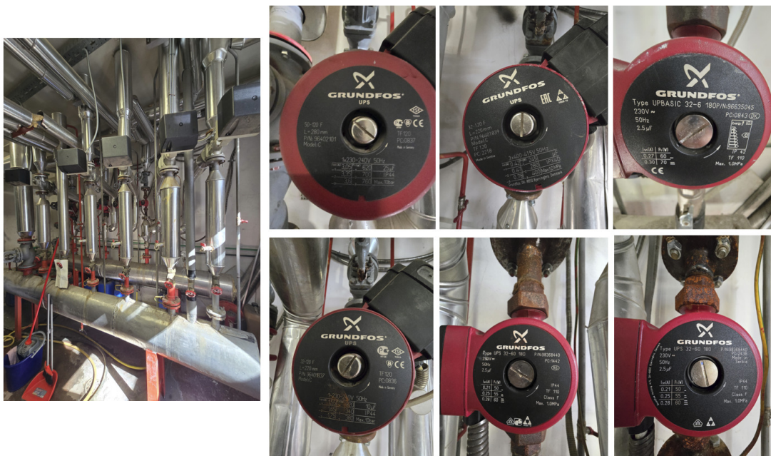
Слика 27: Приказ циркулационих пумпи произвођача Grundfos у машинској сали који полазе од разделника топле воде
