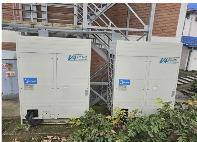
Слика 36: Приказ спољашње јединице произвођача Midea тип: MDV-400(14)W/DRN1(B)
