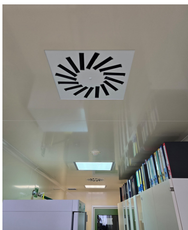
Слика 41: Приказ дистрибутивних елемената (вртложних дифузора) за убацивање ваздуха
