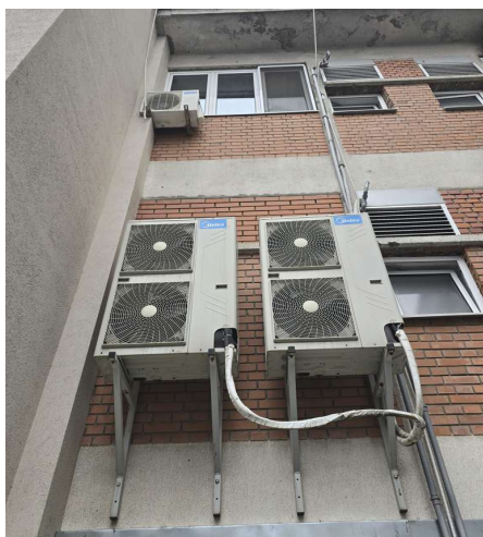
Слика 34: Приказ спољашње јединице произвођача Midea тип: MDV-V160W/DRN1
