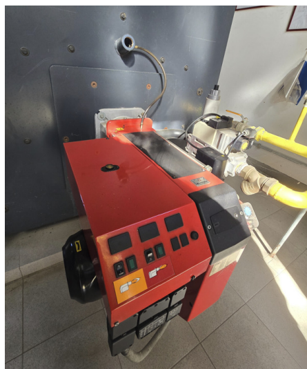
Слика 24: Приказ горњоника гасног котла
