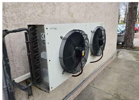
Слика 44: Приказ ваздухом хлађеног кондензатора
