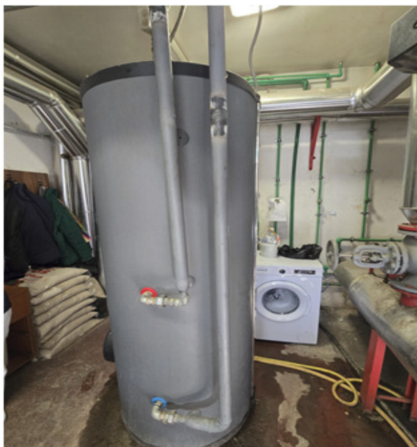
Слика 52: Приказ бојлера за централну припрему СТВ у машинској сали зграде у улици Булевар војводе Степе 457
